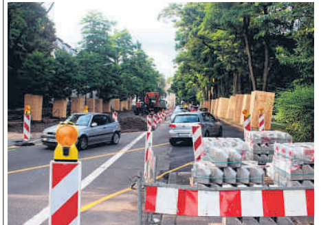
Im großen Bogen müssen Autofahrer an der Niehler Straße – kurz vor dem Nippeser Ortseingang – um die Baustelle kurven. Foto: bes
